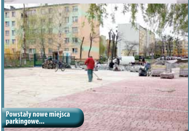
Już wkrótce koniec remontu ul. Prusa
